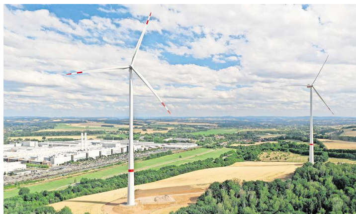
Die ersten beiden Giganten Sachsens: Juwi-Windräder am VW-Werk in Zwickau-Mosel. FOTO: JUWI GMBH / CARSTEN WITTIG
